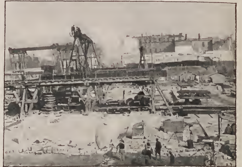
Le chantier de la gare.
